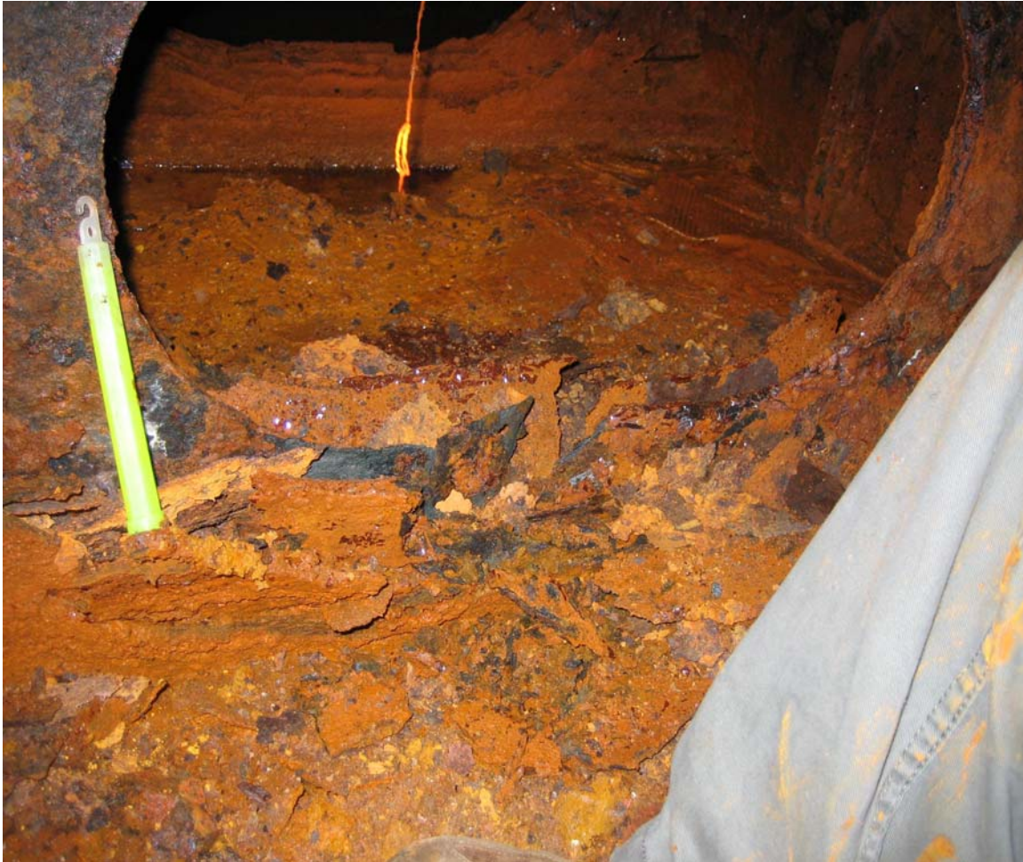
PHOTO – 1 WASTED LONGITUDINAL GIRDER ER STBD
