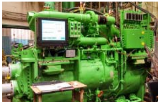
300 Ton HES-C AC Plant
